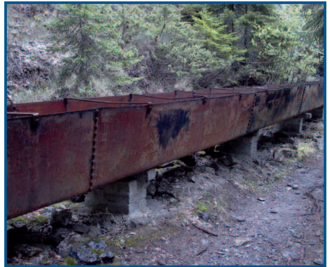
Fig. 6 – Passage du bisse d'Ayent en glissement de terrain. Les pilotis peuvent être rallongés afin de maintenir une pente uniforme.
