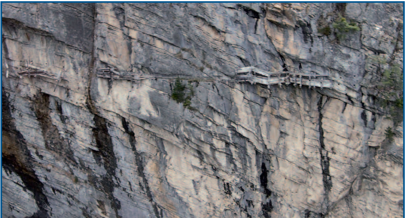
Fig. 4 – La paroi des Branlires: vestiges du Torrent-Neuf de Savièse permettant de traverser une barre calcaire
