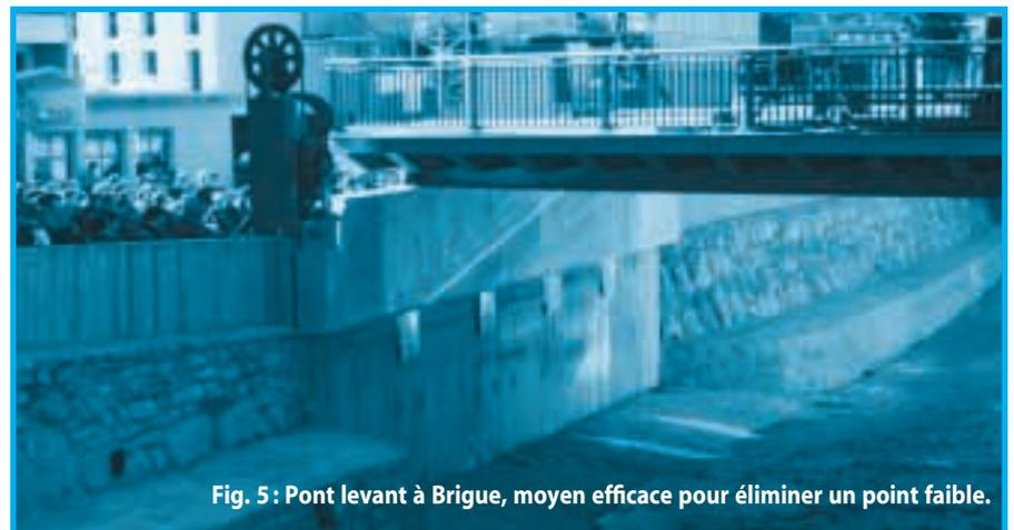
Fig. 5: Pont levant à Brigue, moyen efficace pour éliminer un point faible.
