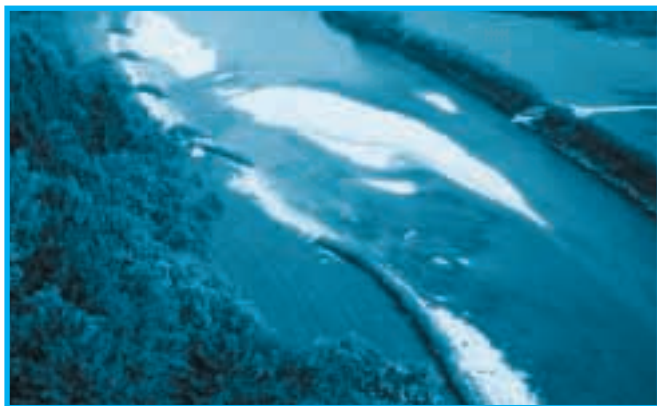
Fig. 2: Le remplacement d'une stabilisation artificielle du profil en long du lit d'un cours d'eau par un élargissement, comme dans cet exemple de la Thur (TG), exige des connaissances techniques élevées et représente une solution durable
