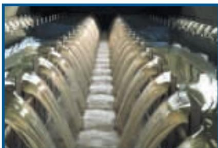
Une des opérations d'épuration des eaux : la décantation lamellaire.
