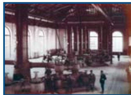
Turbines et pompes au sein du bâtiment
