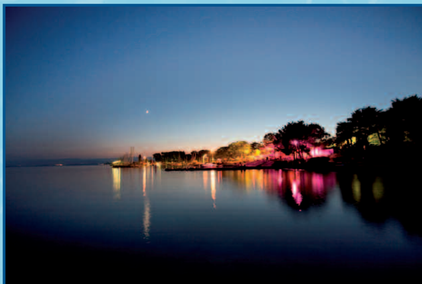
Sous ces eaux dormantes chemine vers le large le long tuyau qui véhicule l'effluent de la STEP de Vidy
