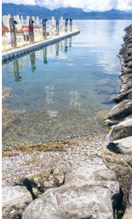
Le bar de 1200 m 2 a été construit sur la zone littorale de Lutry. Photo ASL
