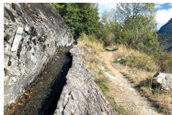
Le Badneri, directement taillé dans la roche, élu bisse de l'année 2023 dans le Haut-Valais Photo Marc Bernard
