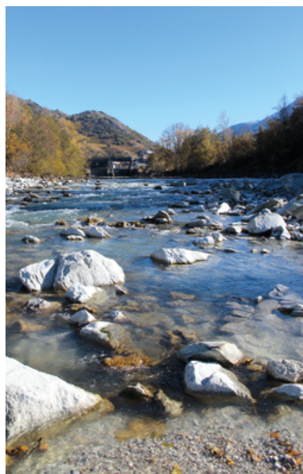
Le Rhône avec un débit résiduel en aval du barrage de Susten (Leuk) Photo Marc Bernard
