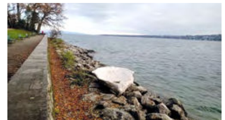
Figure 7. Enrochements semi-naturels servant à la fois à la protection des personnes et des aménagements. Ces milieux qui ont régulièrement tendance à se végétaliser avec le temps constituent également des habitats terrestres recherchés par certains serpents. Perle du Lac (GE), 2023. Photo R. Cuenat
